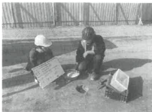
級配夯實度取樣
