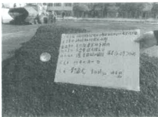
瀝青混凝土溫度抽測
