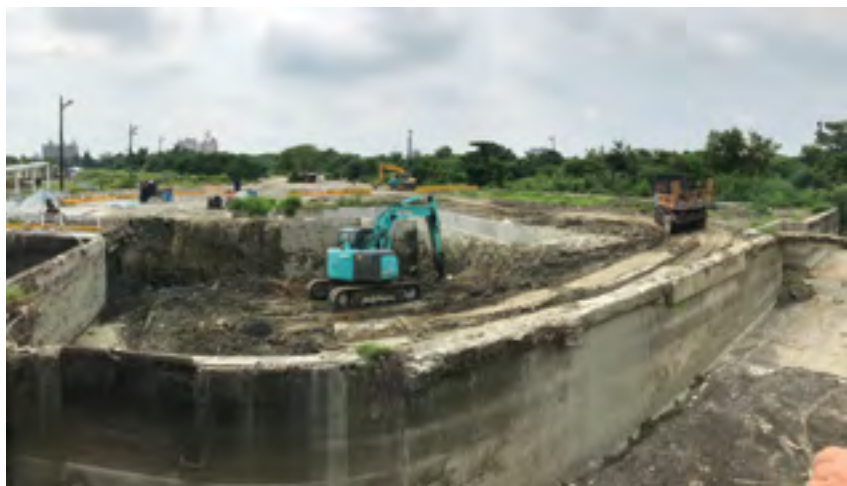
▲ 縣民公園地坑施工。
